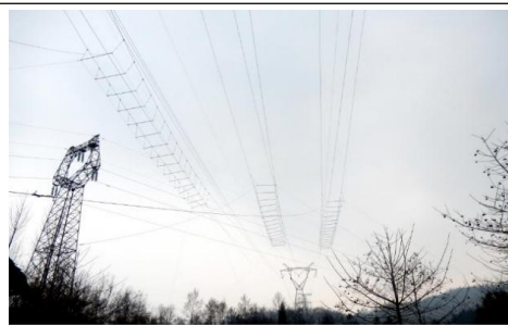
无跨越架（封网）方式示例
