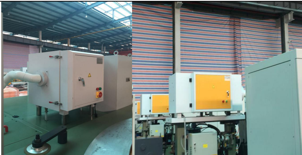
在线处理静电式油烟净化器
