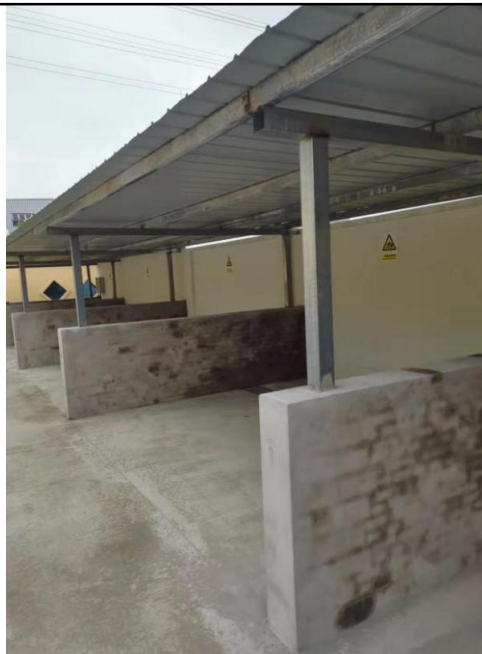
一般工业固体废物贮存场
