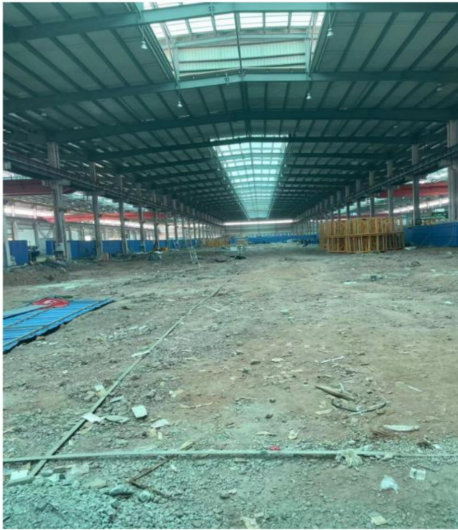
项目厂房现状
