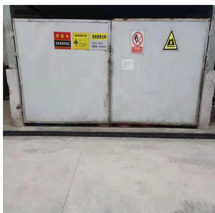
危险废物贮存设施
