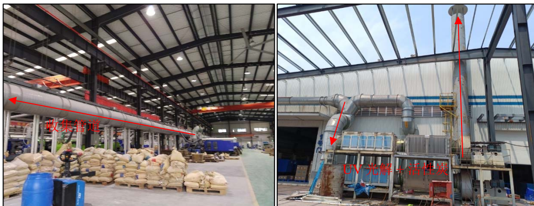
图 2.10-3 注塑废气处理示意图
