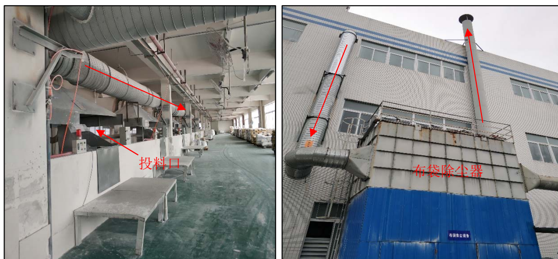
图 2.10-4 除尘处理示意图
