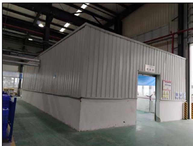
破碎间整体情况
