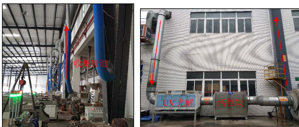
图 2.10-2 PVC 管材生产废气处理示意图
