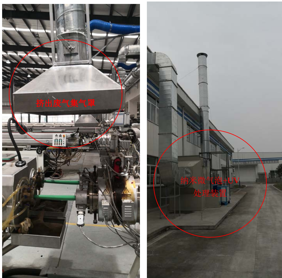
图 2.10-1 PPR 管材生产废气处理示意图
