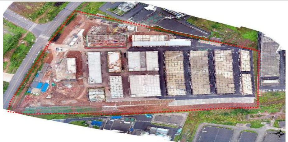
项目建设过程中遥感影像图（2019年）
