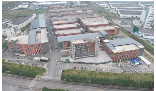
主体工程南侧及施工营地绿化（建成后）
