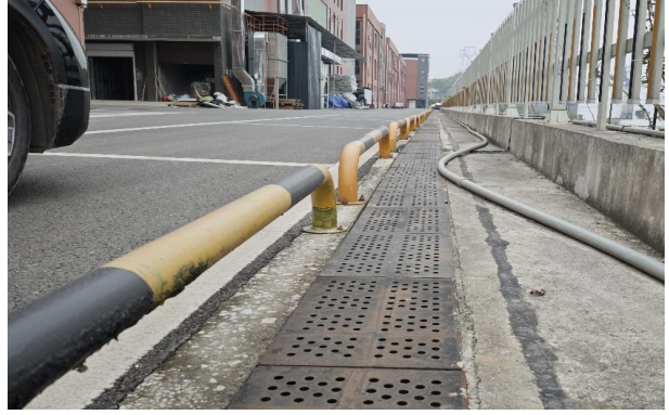
盖板排水沟（建成后）
