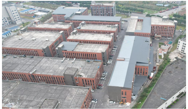
主体工程西侧排水（建成后）
