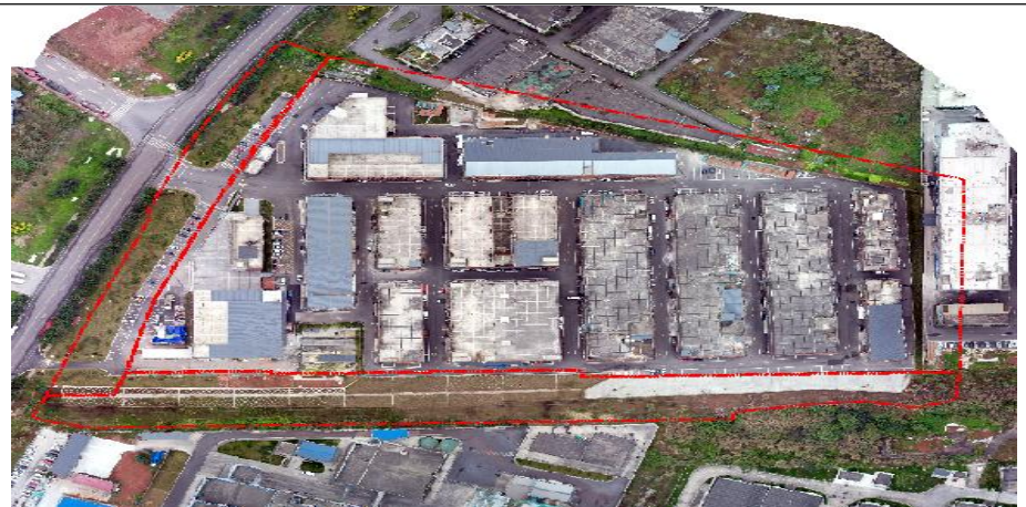
项目建设后无人机航拍影像（2021年）
