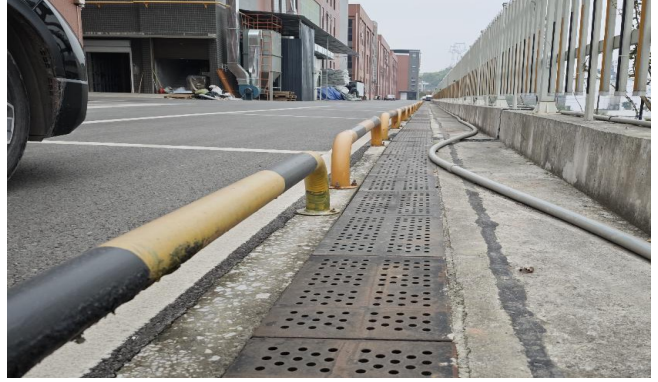
排水沟（建成后）
