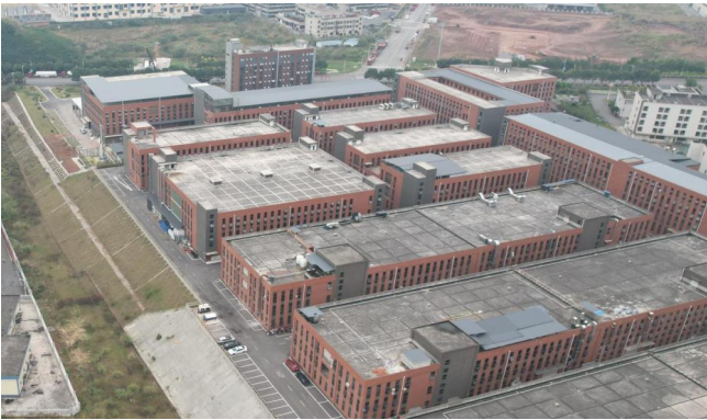
主体工程东侧绿化（建成后）
