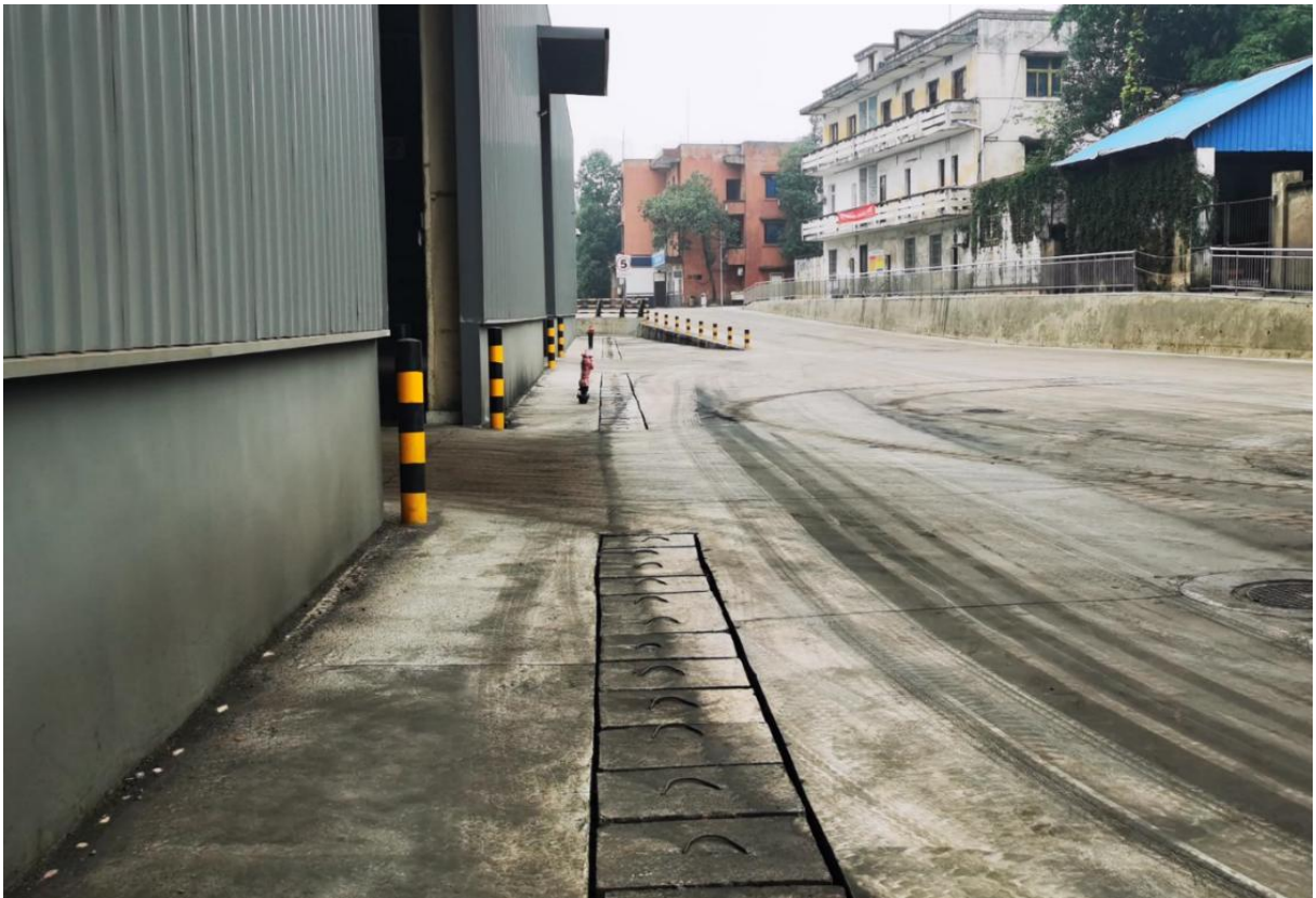
仓库周边盖板排水沟
