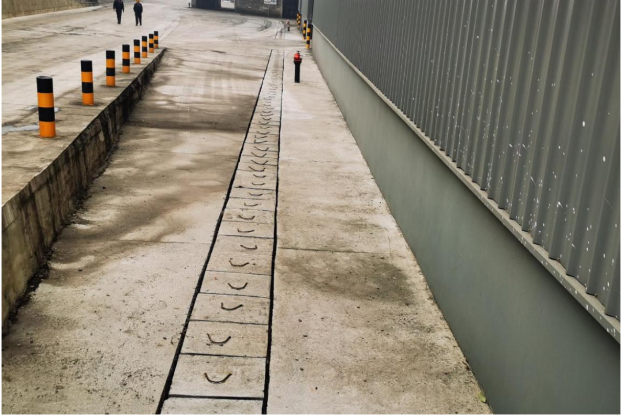
仓库周边盖板排水沟
